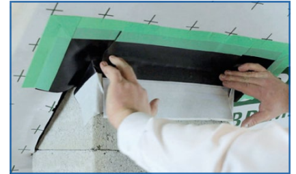
Innenecken mit Putzträger
