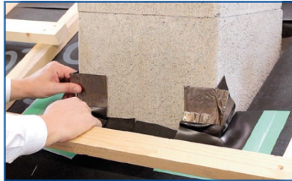
Innenecken ohne Putzträger
